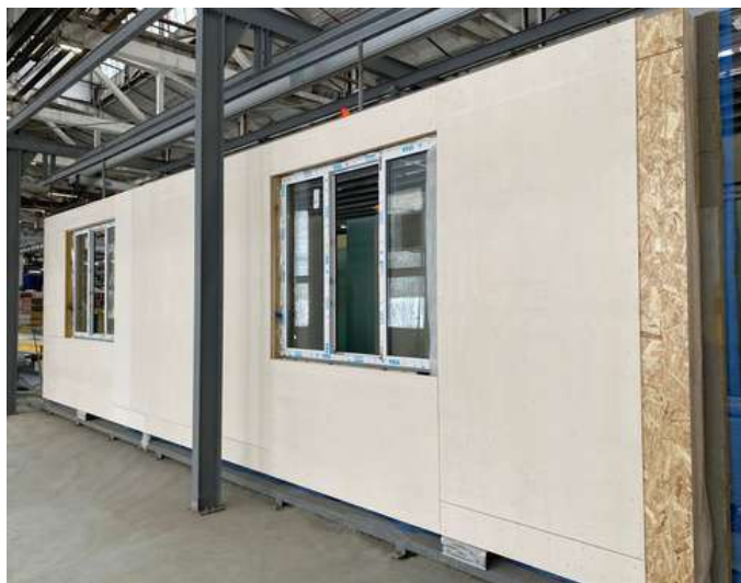
Внутренняя часть наружной стеновой панели
