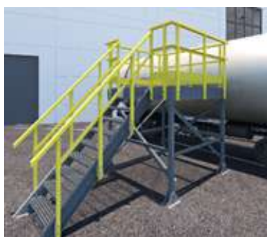
Площадка обслуживания для "Газпром нефть"
